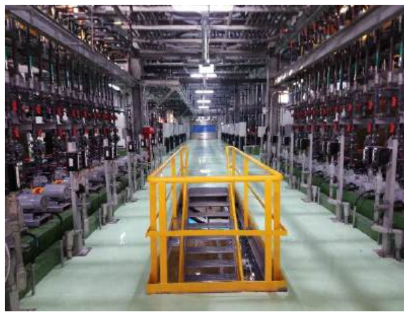
EDR水回收管線工程
